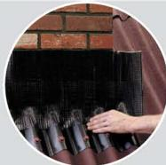
**3** – Укладываем вокруг трубы на стыке трубы с кровлей предварительно согнутую углом полосу ОНДУФЛЕШ-СУПЕР. Завальцовываем края получившегося шва.
