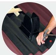
**2** – Труба устанавливается на основание вертикально и фиксируется пластиковыми шпильками.
