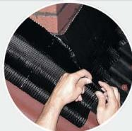
**4** – Стык полосы ОНДУФЛЕШ-СУПЕР фиксируется металлическим профилем. Фиксация производится по всему периметру саморезами.
