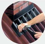
**2** – Отмеряем длину ОНДУФЛЕШ-СУПЕР шире печной трубы. Приклеиваем поверх фартука полосу ОНДУФЛЕШ-СУПЕР. Свободные края ленты отгибаем от печной трубы.
