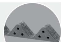
Если заполнитель должен быть вентилируемым, освободите вентиляционные отверстия, прорезанные в нем, например, при помощи отвертки. Чем больше отверстий Вы откроете, тем больше будет вентиляция Вашей кровли.
